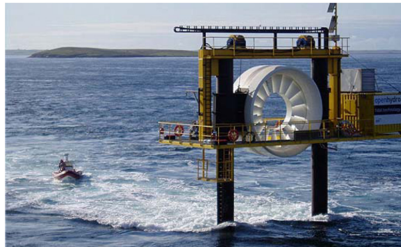
[그림 18] Openhydro사 원형 조류발전 터빈
